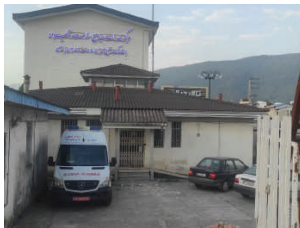
ساختمان قدیمی و فرسوده مرکز خدمات جامع سلامت هچیرود
